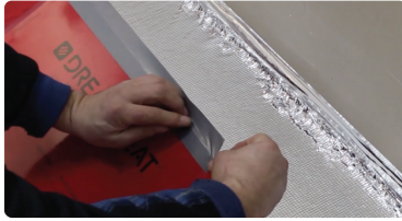
Ⓓ Zamocuj DREAMHEAT • Połącz DREAMHEAT z izolacją za pomocą taśmy
