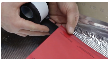
Ⓒ Izolacja zaizoluj miejsc styku złączki i folii DREAM HEAT
