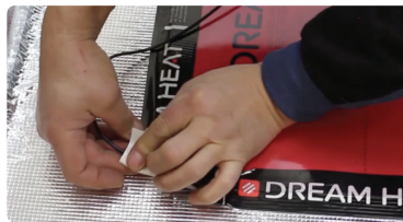
Ⓑ Instalacja Kabla Zainstaluj kabel zasilający do folii DREAM HEAT
